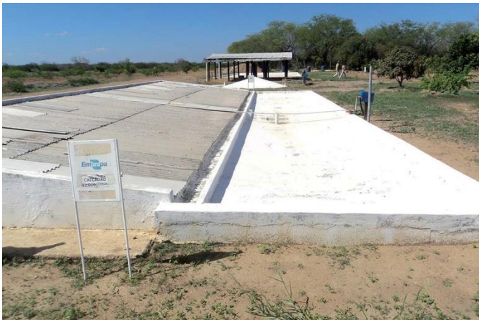
3- Almacenamiento de agua: cisternas, presas de tierra, etc.
