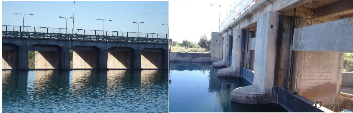
Figura 3. Dique Cipoletti, Mendoza
