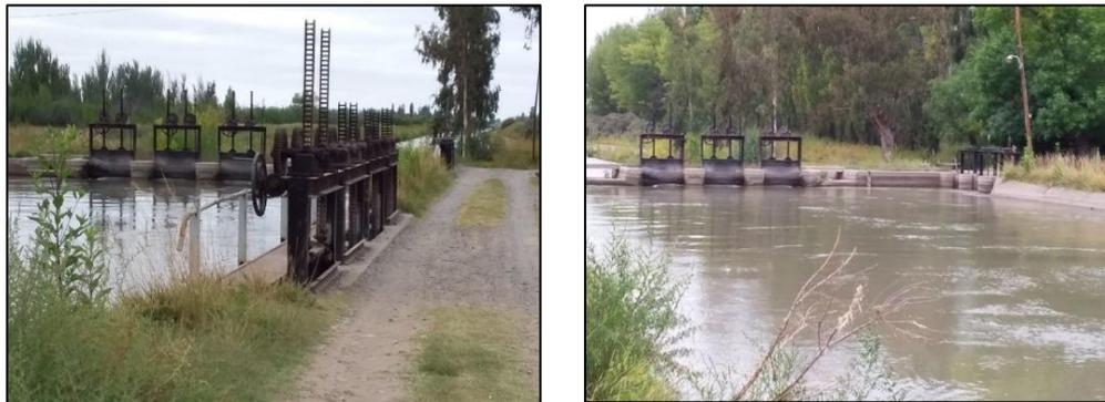
**Figura 28.** Compuertas en el km 89 que dan inicio al distrito de riego. (Fuente: Montenegro *et al.*, 2021).
