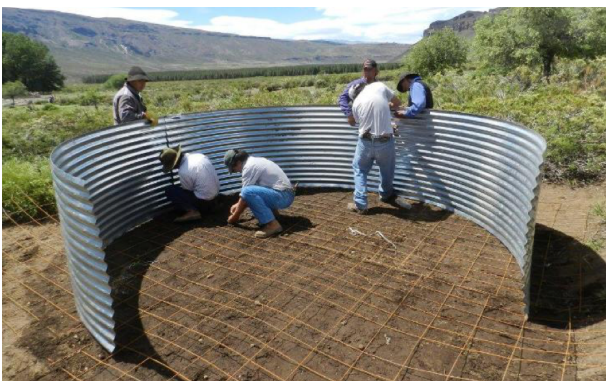
Imagen: Ensamblado de chapas sobre malla sima
