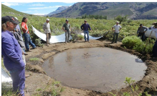
Imagen: Limpieza y compactación del terreno
