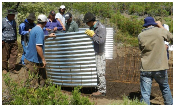
Imagen: Colocación de las chapas encima de la malla sima.
