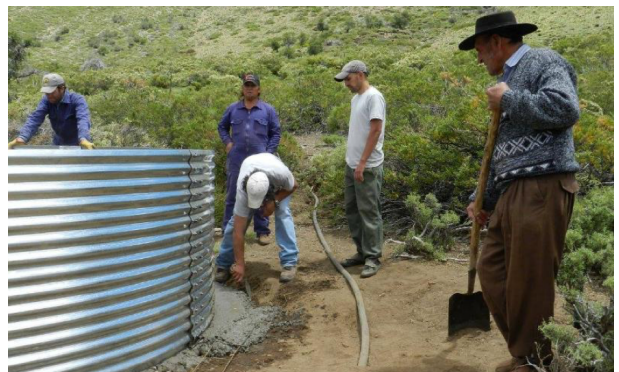
Imagen: Construcción de vereda externa del tanque.
