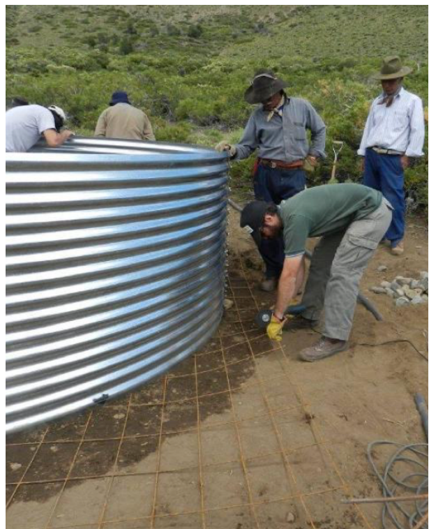
Imagen: Corte de la malla sima excedente
