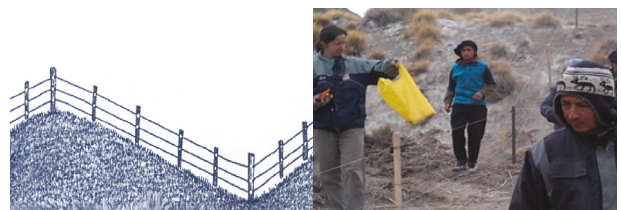
Imagen 5: En la figura de la izquierda observar cómo se coloca un poste en la parte más baja de la quebrada para mantener el alambre siempre a la misma altura. En la foto de la derecha se observa un poste de hierro clavado en la zona baja y otro en la zona alta, para copiar el dibujo del terreno.
