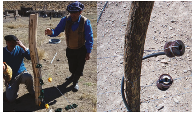
Imagen 23: A la izquierda, vemos un caso real de un alambrado de cinco hilos. Nótese que aquí los aisladores son plásticos y van después de las torniquetas. De esta manera evitamos tener que apagar el electrificador a la hora de ajustar los alambres. A la derecha, vemos aisladores de cerámica reciclados de la compañía de electricidad en un alambrado de 3 hilos.
