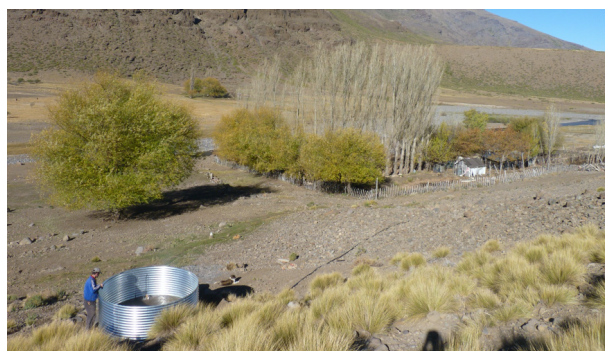
Imagen: Tanque australiano de chapas.
