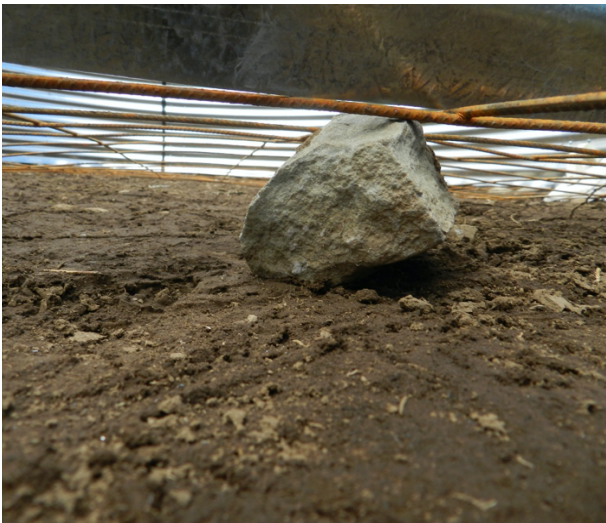
Imagen: Colocación de piedras para separar la malla sima del suelo.
