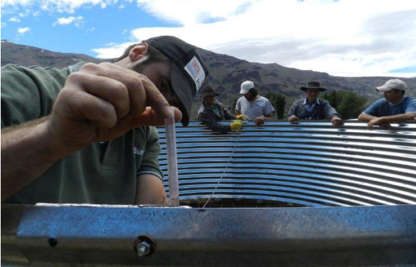
Imagen: Nivelación de las chapas.
