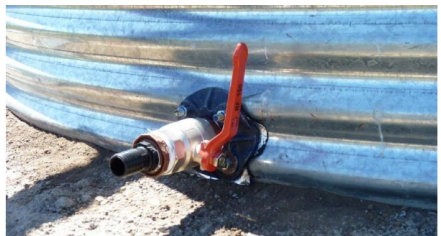
Imagen: Brida de salida de agua.
