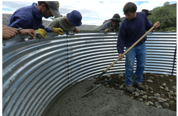
Imagen: Llenado con hormigón para la construcción de la base del tanque.
