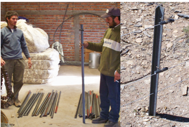
Imagen 7: A la izquierda, postes de hierro Tee, cortados a 1,5 m de largo. A la derecha, poste enterrado 50 cm con 3 agujeros para pasar el alambre. Nótese que el alambre de abajo no tiene aisladores por estar conectado al negativo o tierra, mientras que los dos de arriba conducen electricidad y por eso tienen aisladores de manguera.
