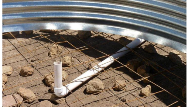
Imagen: Colocación de caño de pvc para el desagote del tanque.
