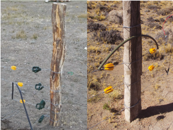
Imagen 6: Postes atadores, importantes para tensar el alambre, con torniquetas y luego aisladores en la foto de la izquierda y con aisladores en la foto de la derecha.
