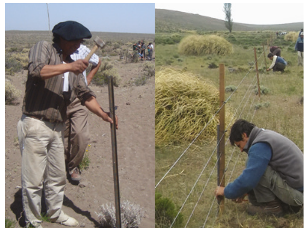
Imagen 8: En la foto de la izquierda podemos apreciar el hierro Tee de 1,5 m siendo enterrado con maza a 60 o 70 cm de profundidad. En la foto de la izquierda, el poste de hierro con una varilla de madera atada. En este caso no se realizan agujeros en el hierro. Nótese que es un alambrado de 5 hilos para cabras, con el segundo, cuarto y quinto alambre, contando de abajo hacia arriba, con aisladores debido a que están electrificados.
