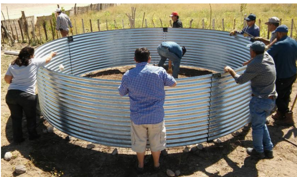
Imagen: Chapas del tanque colocadas sobre piedras.
