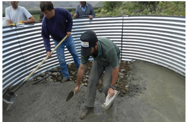
Imagen: Llenado con hormigón para la construcción de la base del tanque.
