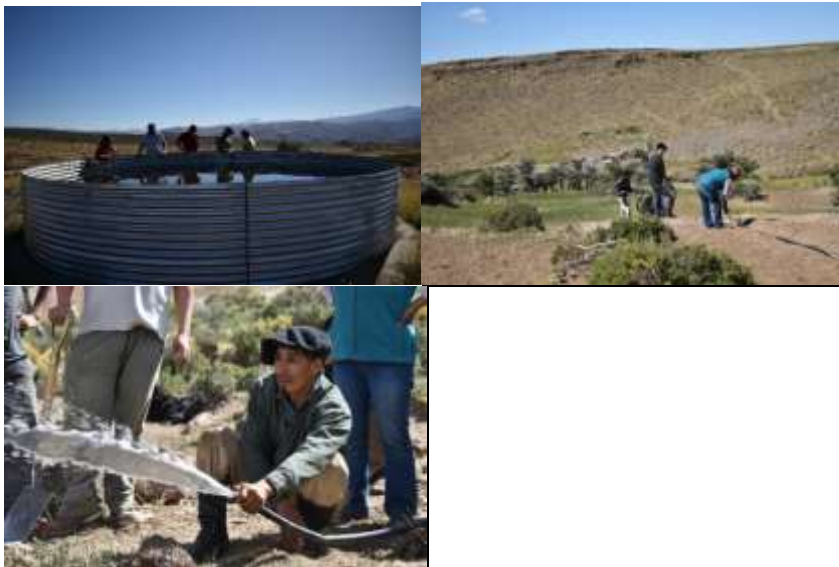
Foto 21: Almacenamiento de agua en tranque australiano. Foto 22: transporte de agua mediante mangueras. Foto 23: Productor demostrador de Zapala, Neuquén, con acceso al agua en su casa producto de la captación, almacenamiento y transporte.
