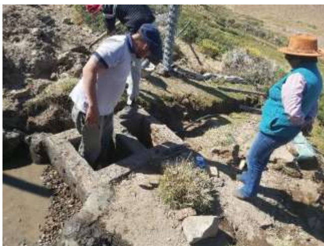
Foto 3. Captación y distribución de agua en un campo demostrador de Zapala, Argentina
