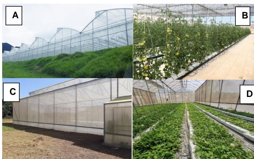
Figura 47. Estructuras para agricultura protegida. a. Estructura tipo multitúnel; b. Estructura tipo túnel, Empresa Cultivos Selectos, Cerro Punta, Chiriquí; c. y d. Estructuras tipo arco con apertura cenital, Cooperativa El Progreso, ubicada en Agua Buena, Provincia de Los Santos. Fotos: Javier Pittí (IDIAP) y Anobel Barba (IDIAP).
