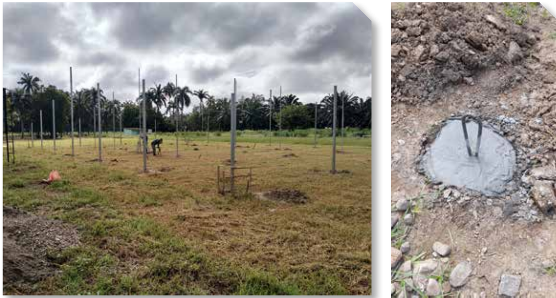
Figura 13. Empotramiento de los pilares.
