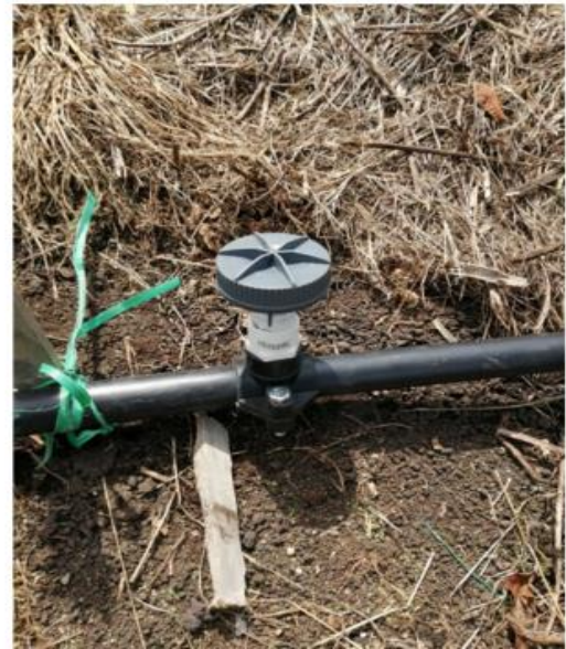
Gráficos 6 y 7. Sistema de desaireación al final de la línea
