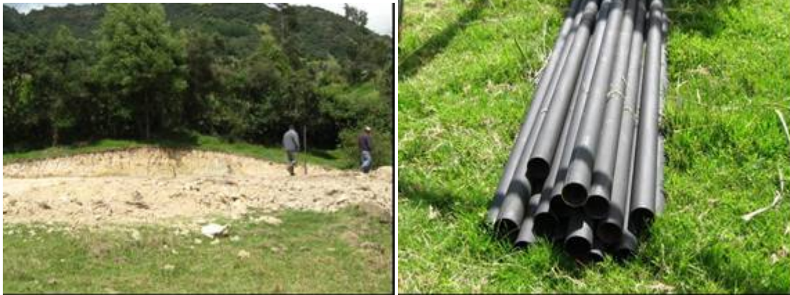
Fotografías 53. Explanación y llegada de los primeros materiales al sitio
