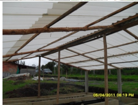
Instalación de cubierta con madera y teja plástica
