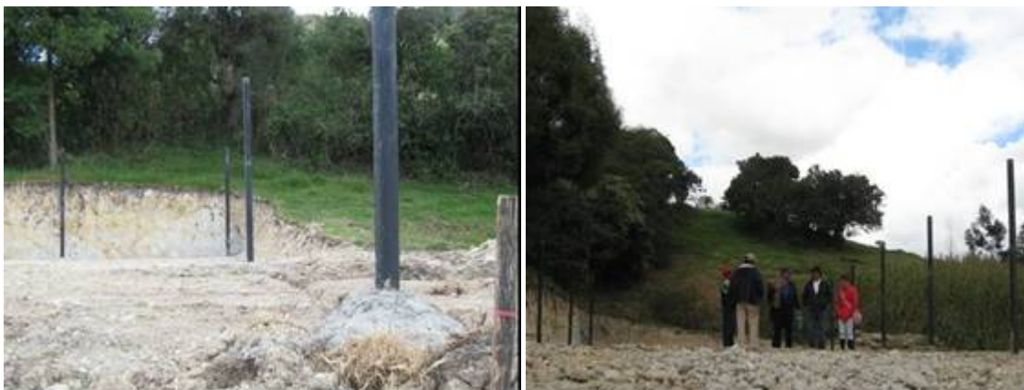
Fotografías 54. Columnas de la planta
